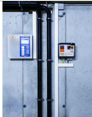
Steuerungen für Brandmeldeanlage und Schmutzwasserpumpe
