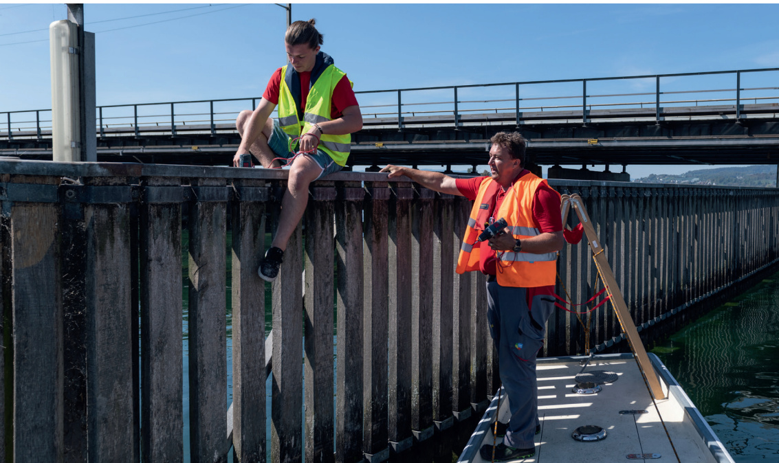
Arbeiten mittendrin: oben der Himmel, unten das Wasser
