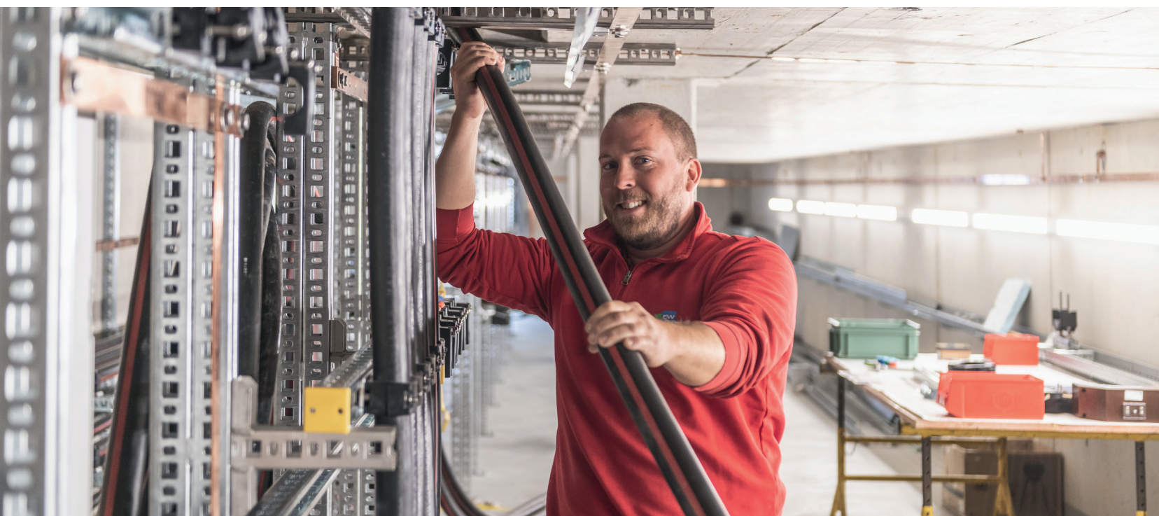
Fabian Neururer, bauleitender Netzelektriker, beim Einschleifen des Hochspannungskabels in die Hochspannungszelle
