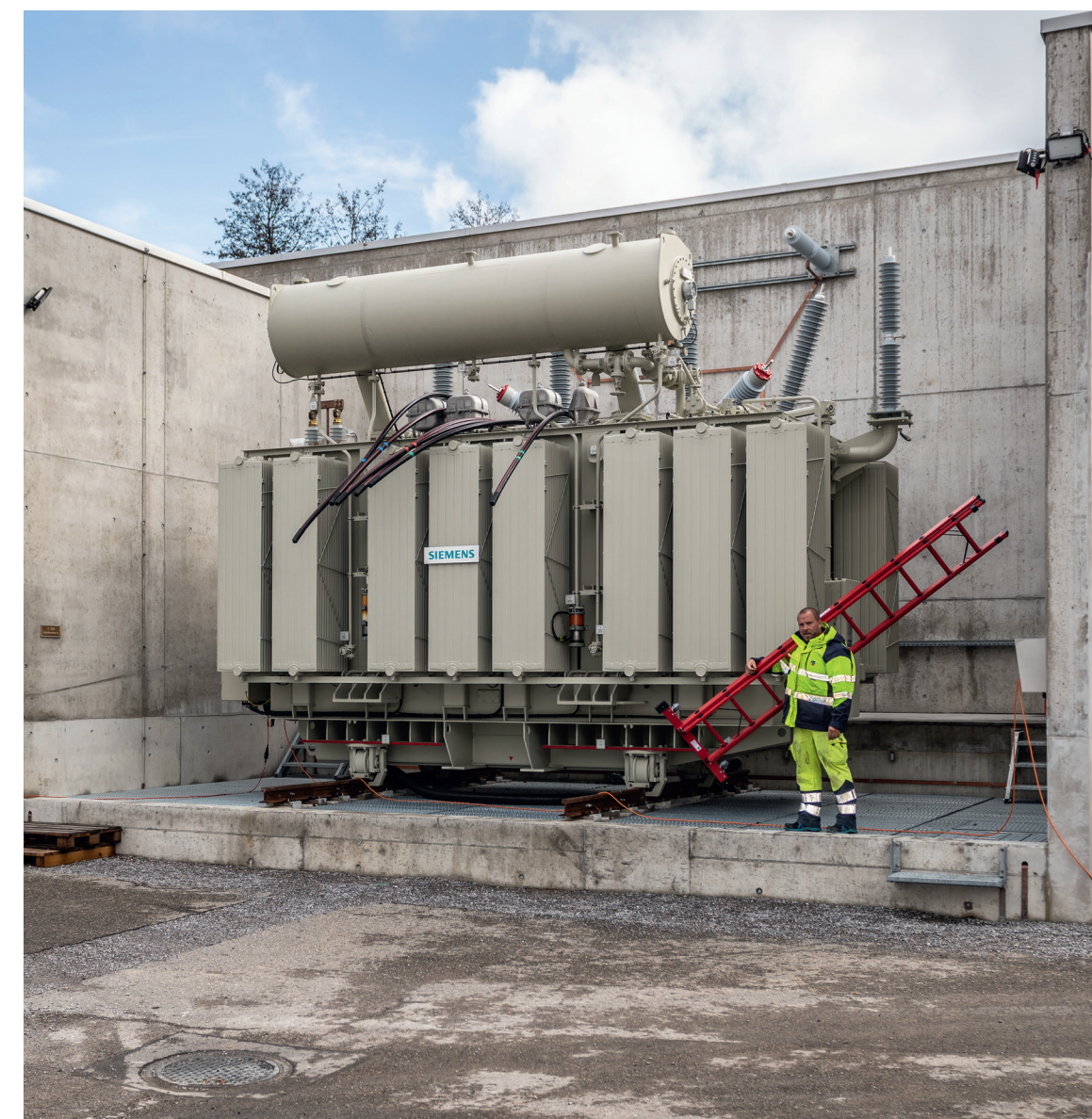
Einer der beiden Transformatoren des neuen Unterwerks wird für den Anschluss an das Hochspannungskabel vorbereitet
