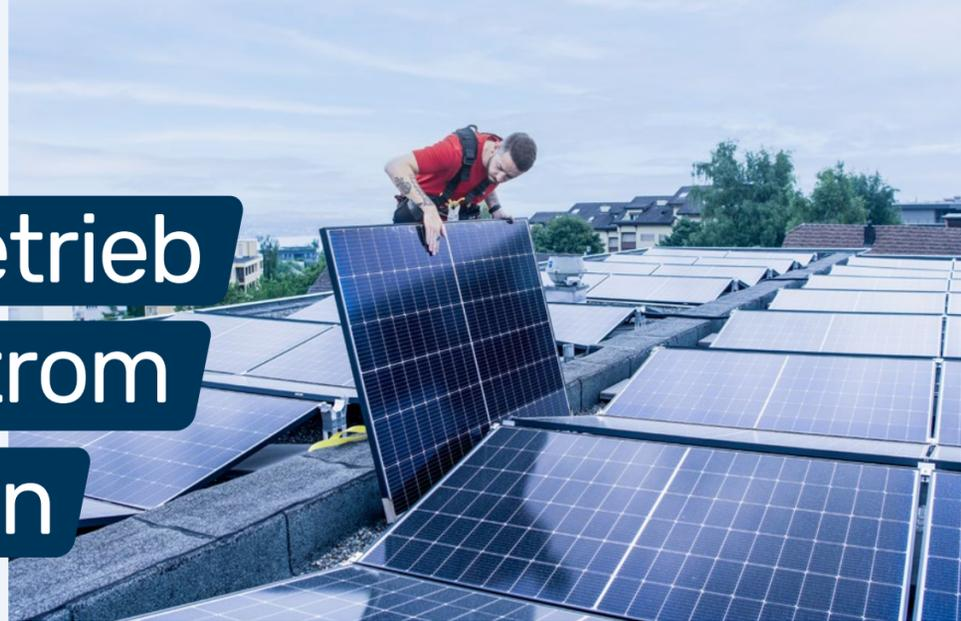
Ein Mitarbeiter der Elektroinstallation der EW Höfe bei der Montage von PV-Modulen auf dem Dach der Theiler AG
